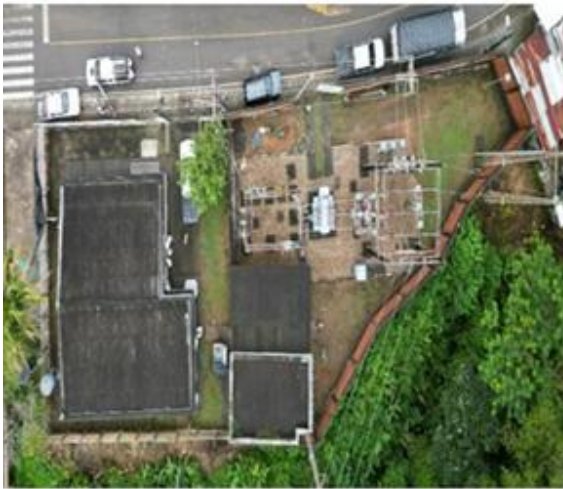
Vista aérea Subestación Norcasia (Norcasia – Caldas)
