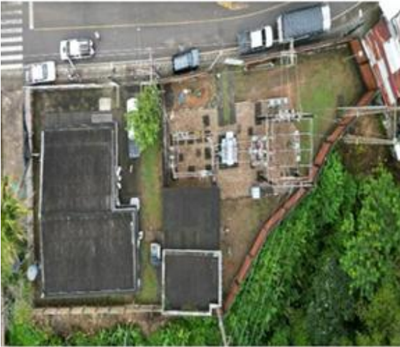
Vista aérea Subestación Norcasia (Norcasia – Caldas)
